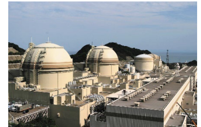
原子力発電所
