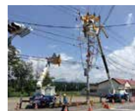
無停電工法による 高圧電線移線作業
