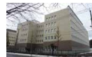
北海道警察学校(電気設備)
