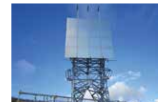
山岳部への電波反射板新設工事
